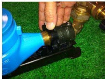
⑭ メーターの取付け完了
