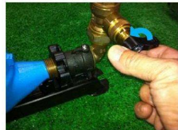
⑮ 止水栓を開き異常の有無確認
